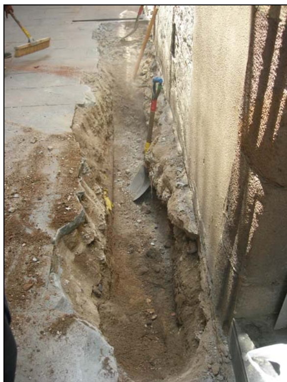
36. Tram de rasa al c/ de la Palla, serveis.
