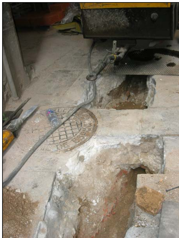
45. Tram de rasa al c/ de la Palla, serveis.
