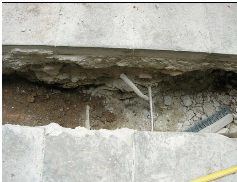
9. Vista de la rasa al c/ Cardenal Casañas.
