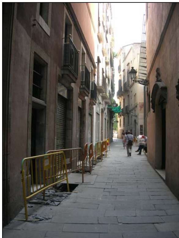
33. Vista de les obres al C/ de la Palla.
