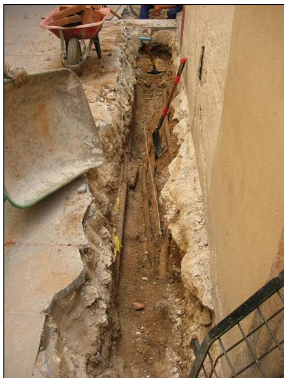
37. Tram de rasa al c/ de la Palla, serveis.
