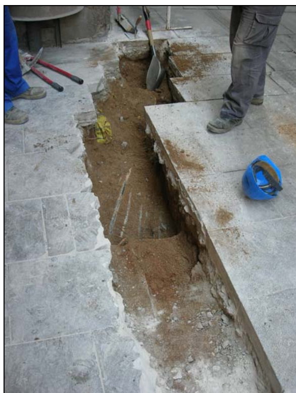
23. Tram de rasa a la Plaça del Pi, instal·lació dels nous tubs..
