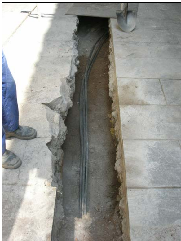
27. Tram de rasa al c/ Cardenal Casañas, serveis.
