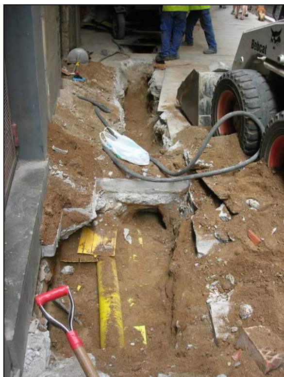
46. Tram final de la rasa al c/ de la Palla, serveis.
