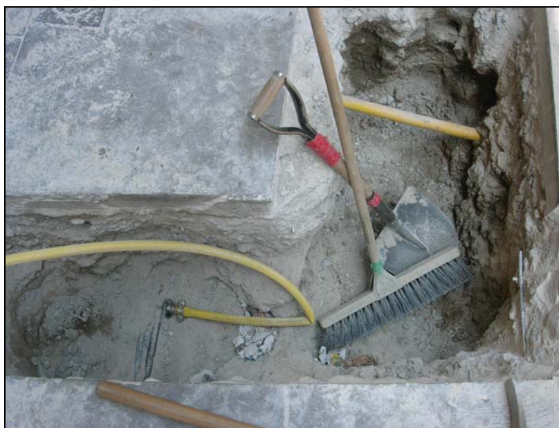
4. Inici de la rasa al c/ Cardenal Casañas.
