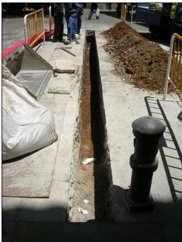
22. Tram de rasa a la Plaça del Pi.
