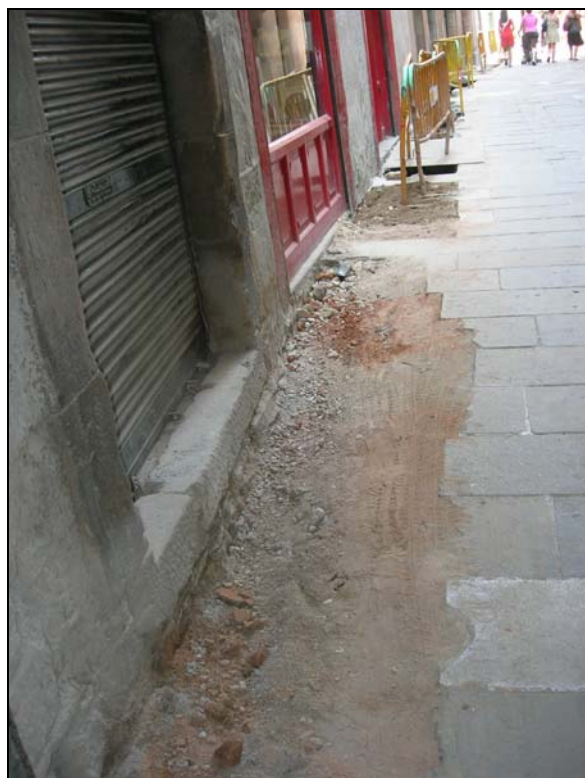
39. Tram de rasa al c/ de la Palla abans de buidar.
