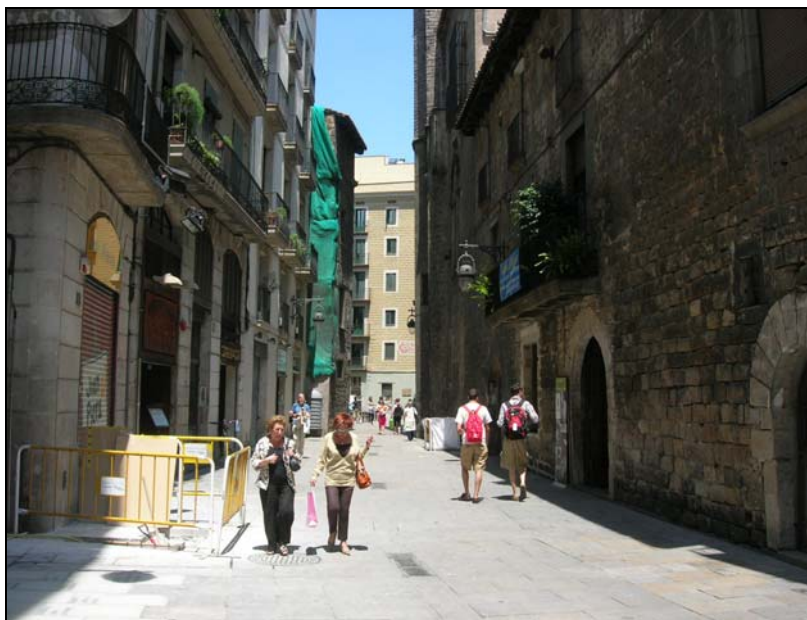
1. Inici dels treballs al c/ Cardenal Casañas.
