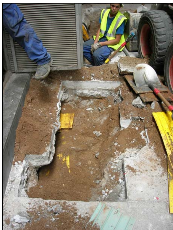
42. Tram de rasa al c/ de la Palla, serveis.
