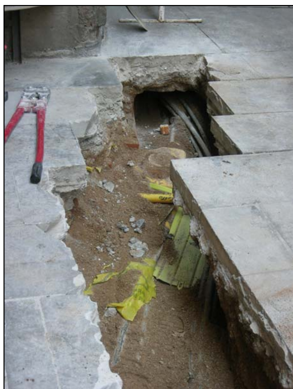
26. Tram de rasa al c/ Cardenal Casañas, serveis.
