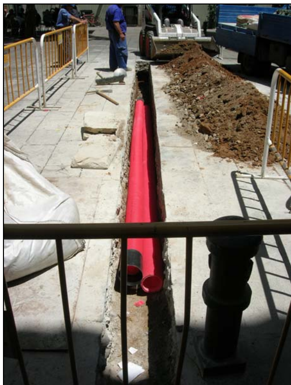
23. Tram de rasa a la Plaça del Pi, instal·lació dels nous tubs..
