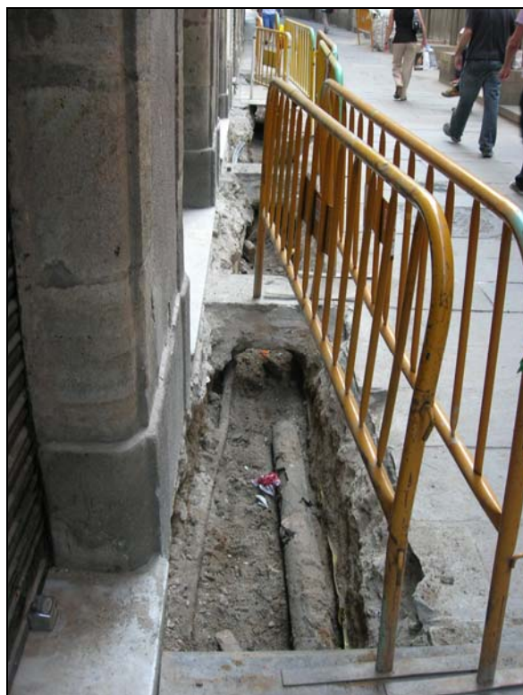
34. Tram de rasa al c/ de la Palla, serveis.
