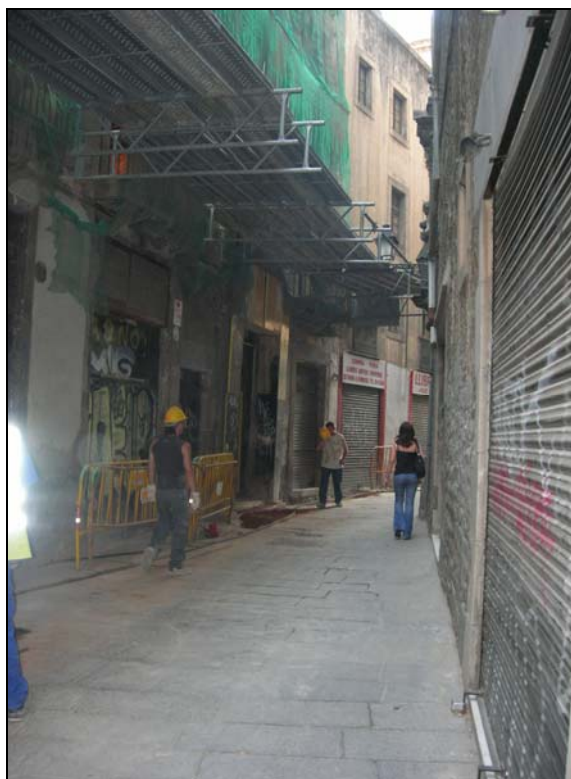
31. Inici de la rasa al c/ de la Palla.
