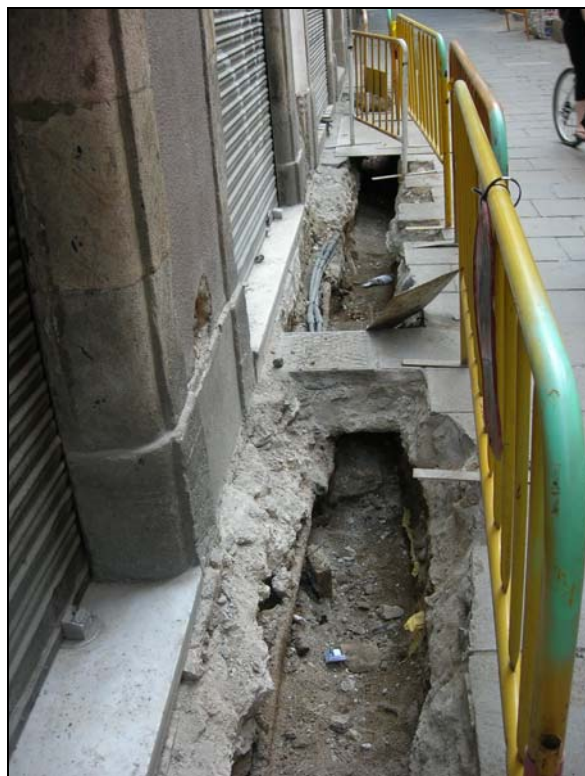
35. Tram de rasa al c/ de la Palla, serveis.
