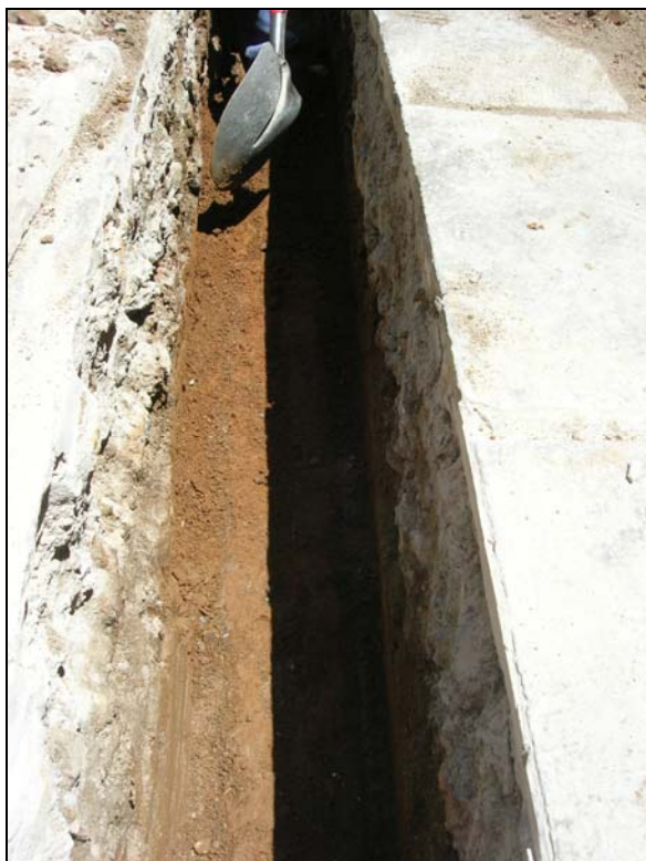
21. Tram de rasa a la Plaça del Pi.
