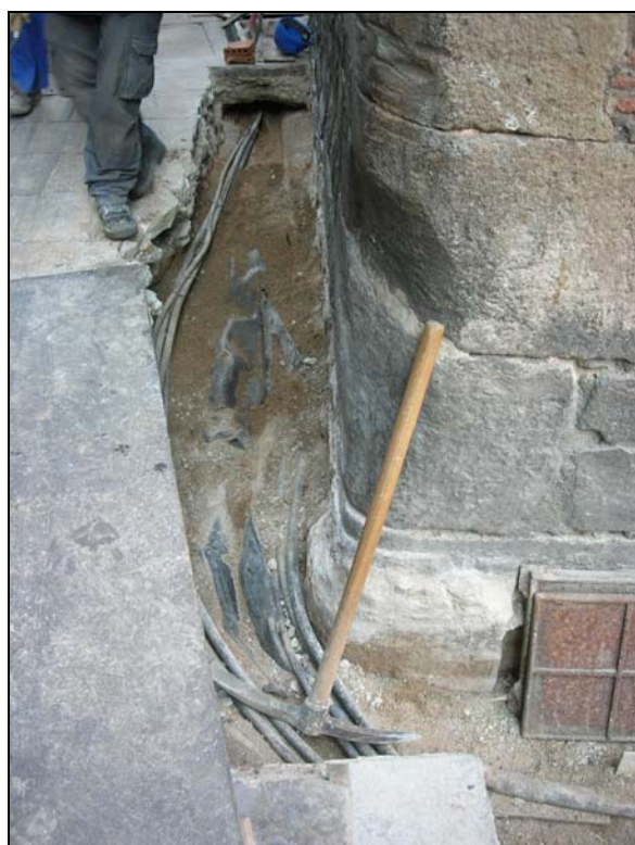
30. Tram de rasa al c/ Cardenal Casañas-Plaça del Pi, serveis.
