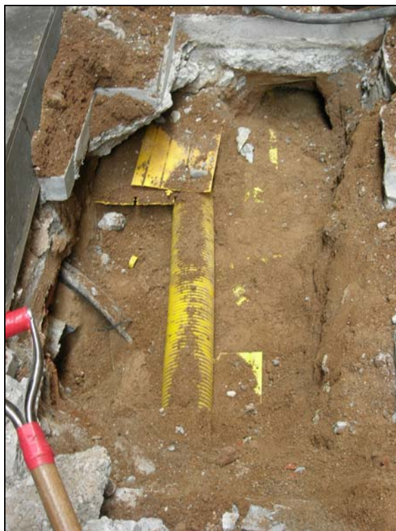
43. Tram de rasa al c/ de la Palla, serveis.
