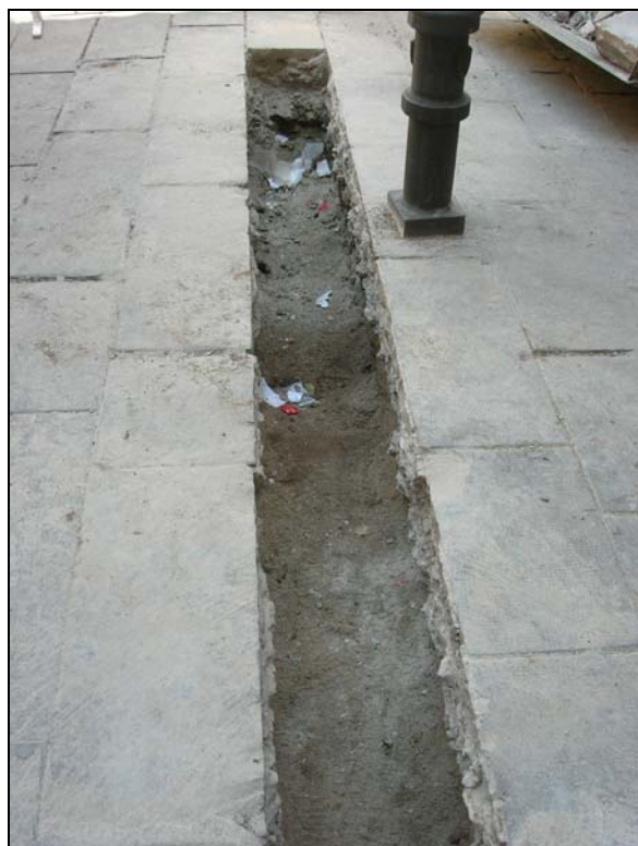
18. Tram de rasa a la Plaça del Pi..
