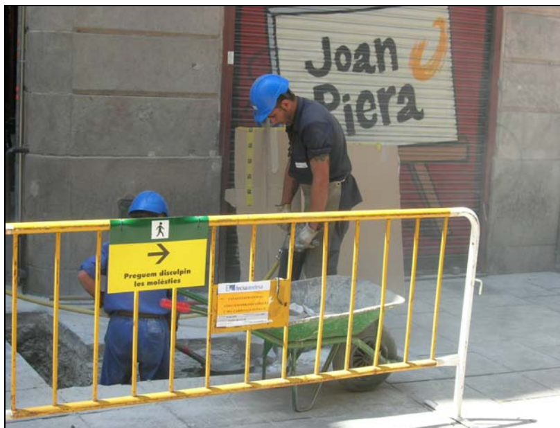
5. Inici dels treballs al c/ Cardenal Casañas.
